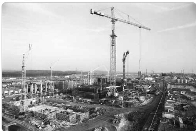
Obr. 1 Stavba elektrárne v Dukovanoch v roku 1981.
