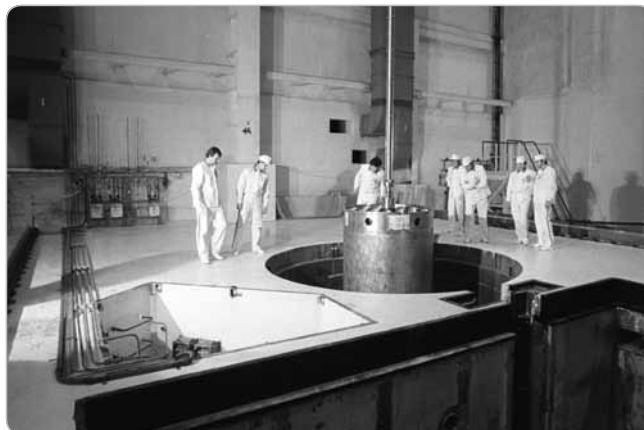
Obr. 2 Kontajner s čerstvým palivom spúšťajú do šachty v susedstve reaktora elektrárne Dukovany.
