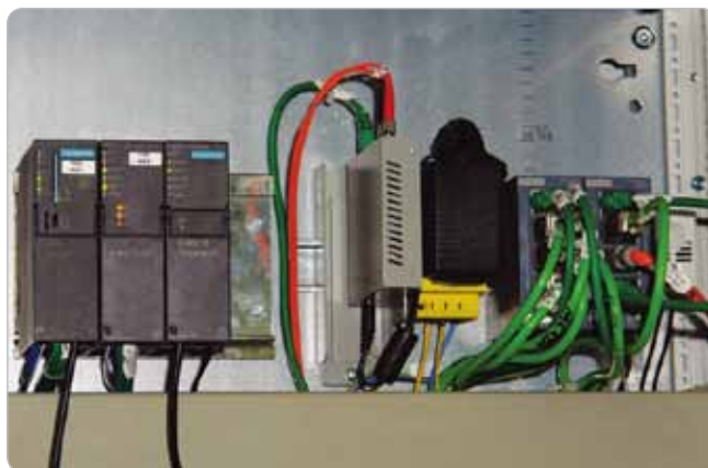
Obr. 4 Riadenie montážnej linky má na starosti fail-safe riadiaci systém Simatic S7-317 F 2PN/DP.
