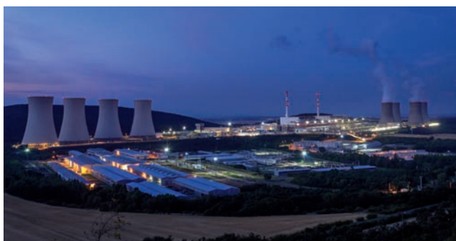
Atómová elektráreň Mochovce (Foto: SE, a. s.)
