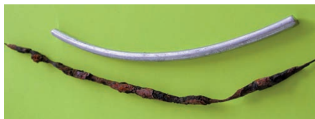
Koróziou poškodený drôt FeZn – 15 rokov po inštalácii
