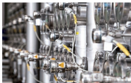
Membránová filtrácia je najdôležitejším aspektom procesu frakcionácie srvátky a mlieka: tlak a teplota sa v tomto prípade monitoruje pomocou prístrojov Cerabar PMP55 a iTHERM TM411.
