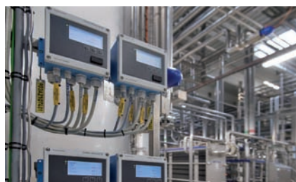
Záznamové zariadenia o spotrebe energie dôsledne monitorujú účinnosť procesov: zariadenie EngyCal RH33 umožňuje vzdialenú kontrolu nameraných údajov.
