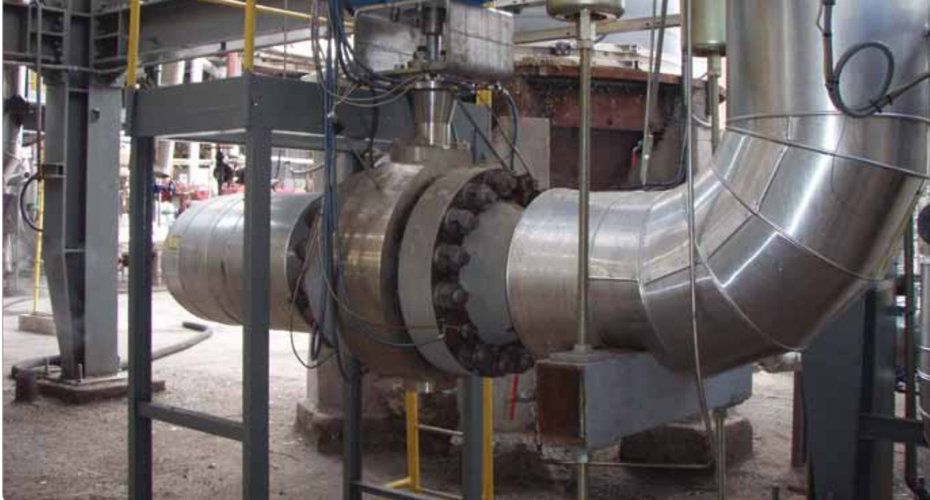
Obr. Systém MPS nasadený na VT klapke syntézneho plynu na vstupe do syntézneho reaktora
