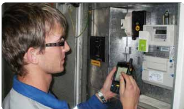
Obr. 1 Elektromontér vykonávajúci automatický odpočet stavu elektromera
