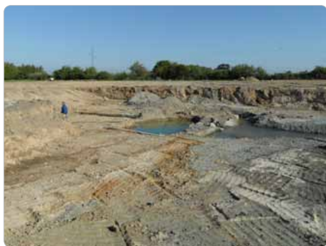
Obr. 3 Problémy s vysokou hladinou podzemní vody
