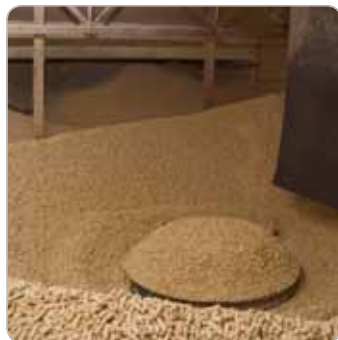
Obr. 3c Kotelňa ZŠ Korňa, sklad peliet s pružinovým miešadlom (90 + 150 kW) v kaskádovom zapojení
