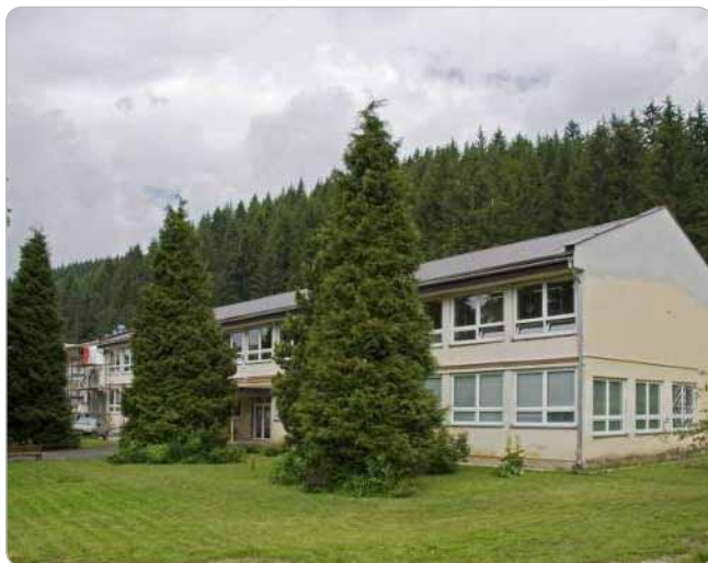
Obr. 3a Objekt ZŠ Korňa
