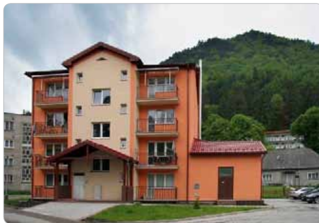
Obr. 5a Kotelňa na pelety v prístavbe domu, Lubochňa
