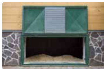
Obr. 1b Rodinný dom Banská Bystrica – kotol na drevnú štiepkou, menovitý výkon 20 kW, sklad drevnej štiepky v suteréne
