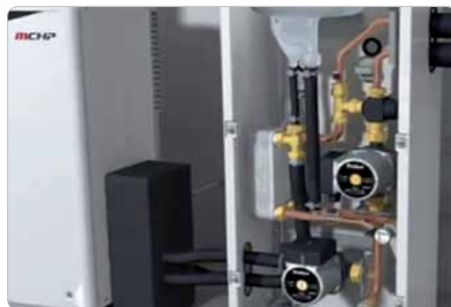
Obr. 2 Mikrokogenerační jednotka složená z komponent[5]
