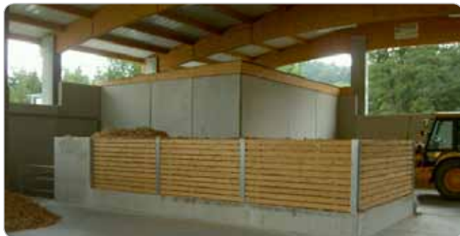
Obr. 9 PVA Alland, HVR 800 kW - Zásobník paliva (zdroj: Polytechnik GmbH, Weissenbach a.d. Tr., Rakúsko - 2009)
