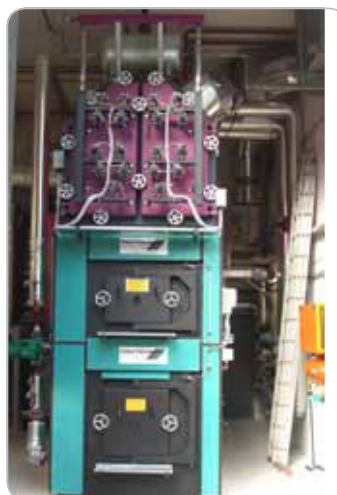
Obr. 12 PVA Alland, HVR 800 kW - Spaľovacie zariadenie na drevné štiepky spolu s tepelným výmenníkom v zostave nad sebou (zdroj: Polytechnik GmbH, Weissenbach a.d. Tr., Rakúsko - 2009)
