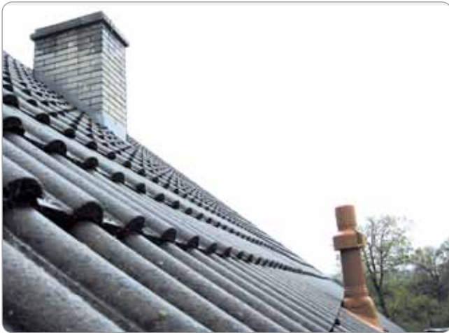
Obr. 4 Odvod spalín. Vľavo pôvodný komín klasického kotla. Vpravo komín kondenzačného kotla.
