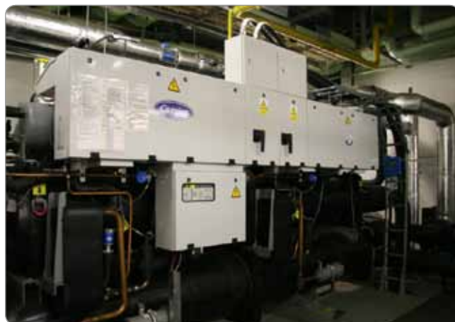
Obr. Reverzný chladiaci stroj Carrier schopný pracovať aj v režime tepelného čerpadla
