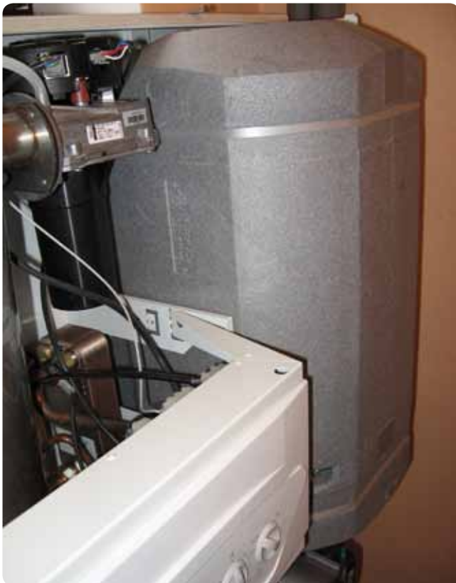
Obr. 3 Integrovaný zásobník na ohrev vody. V ľavej časti dolu je doskový výmenník, hore vzduchový ventilátor. Zásobník teplej vody uložený v tepelnej izolácii je vpravo.
