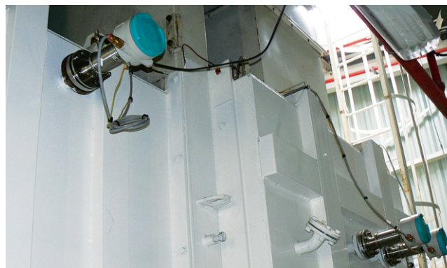
Obr.3 Pohľad na technológiu – vstupný bod spracúvaného odpadu. Na reguláciu koncentrácie kyslíka sa používa prísun dusíka.
