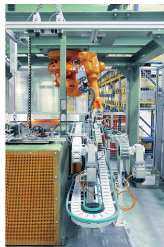
Obr.5 a 6 Pohľad do vnútra robotizovaného pracoviska s robotom IRB 1600 inštalovaným zo stropu
