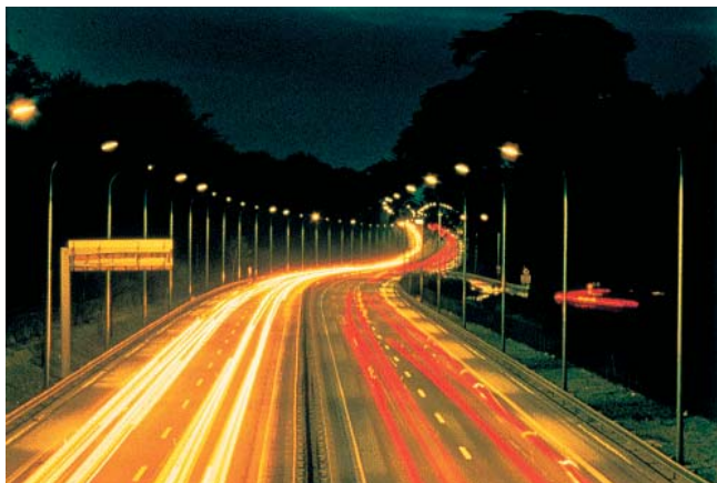
Obr.1 Osvetlenie prostredníctvom sodíkových vysokotlakových výbojok
