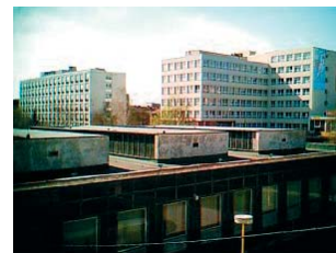
Obr.4 Pohľad na využitelnú časť strechy posluchární
