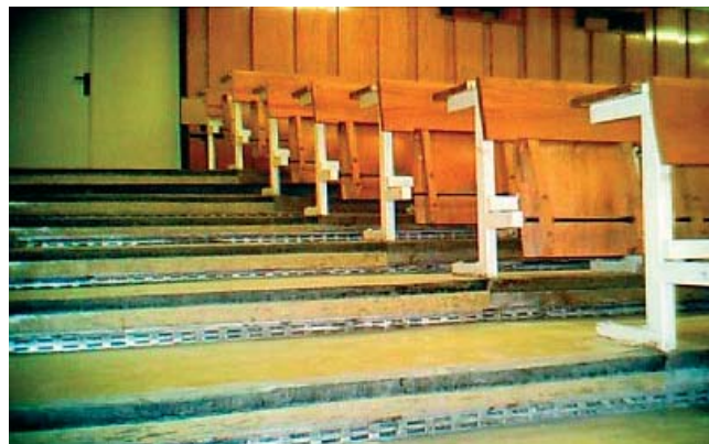
Obr.2 Podlahové odsávacie otvory v posluchárni P 26
